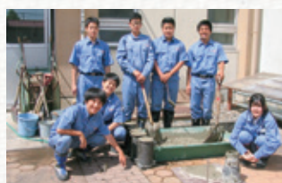
コンクリート実習
